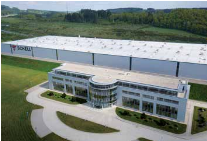
Werk 1 Produktion mit Verwaltungsgebäude und Schulungszentrum
